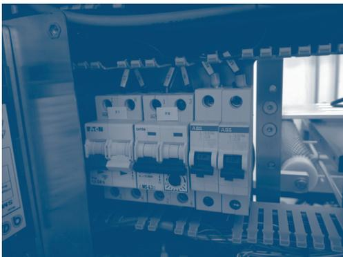
Überprüfen, ob die Anschlüsse und die Verkabelung korrekt installiert und befestigt wurden (insbesondere die, die zu den Platinen und den Druckköpfen führen) und alle Schalter im Schaltschrank aktivieren. Das Schutzgehäuse des Schaltschranks wieder schließen.
